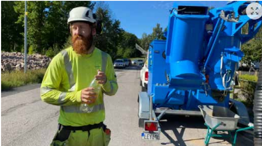
“Som natt och dag jämfört med att gräva för hand”, säger Tobias Asp som just nu jobbar med att byta ut elskåpet i Åtvidaberg. Foto: Lotta Willsäter
